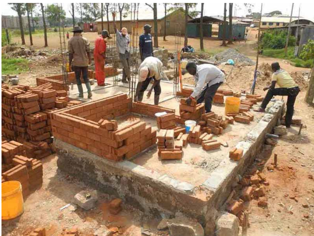
Abb. 38: Bau von Sanitäranlagen, Kibera Public Space Project 06
