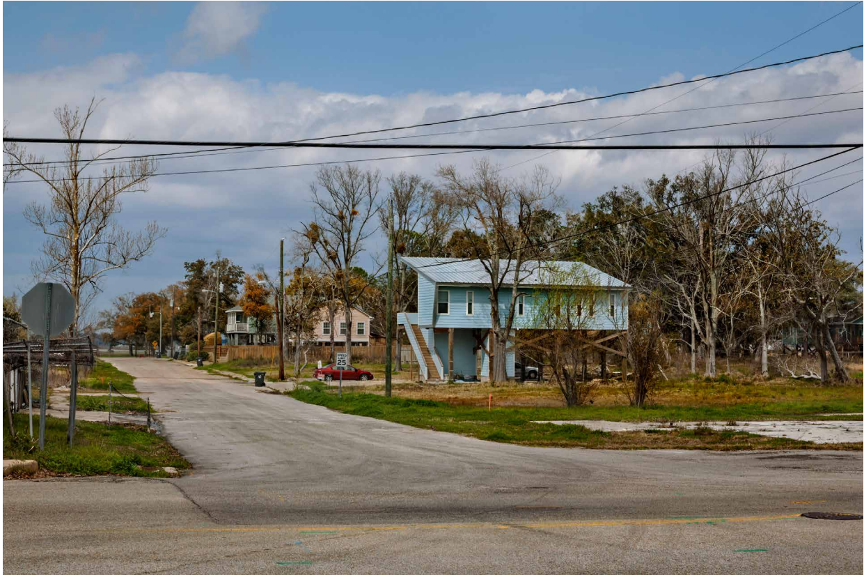
Abb. 14-15: Einfamilienhäuser für Menschen mit niedrigem Einkommen aus dem Wiederaufbau nach der Sturmkatastrophe „Katrina“.
